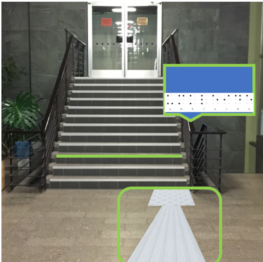
Aufkleber Blindenleitsystem, Stufenkontraste, taktile Beschriftung am Handlauf. Foto-Montage: „Frankenbad bleibt Schwimmbad“
